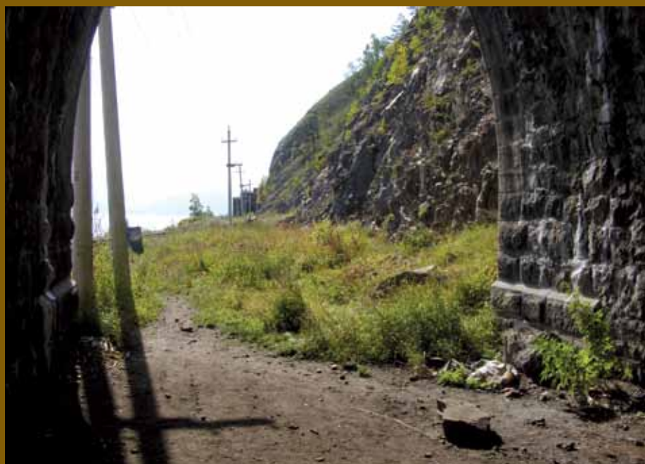
Pohled z bájného tunelu č. 39 na jezero
