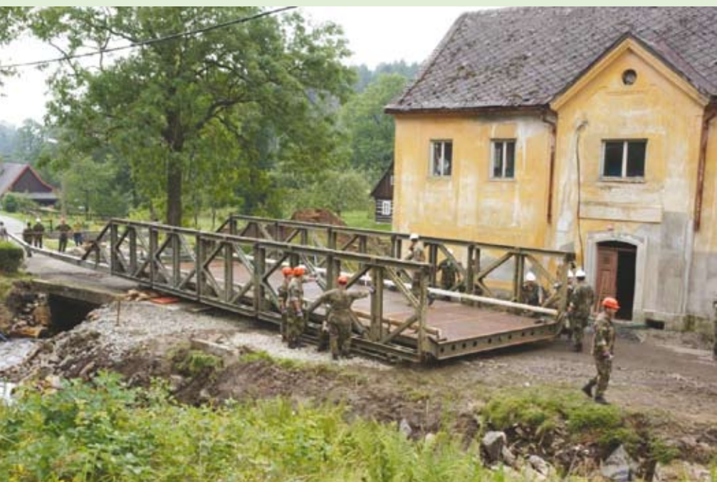
Kompletní most vysunutý nad překážku
