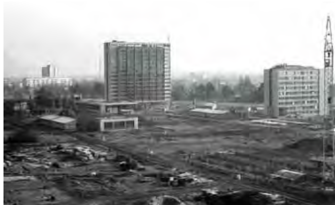
Pohled na staveniště s budovaným Novým internátem (polovina 70. let)
